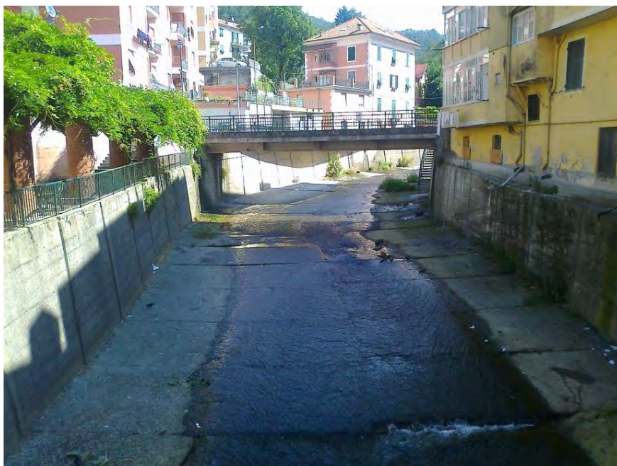
Figura 3: Un tratto urbano di corpo idrico con fondo totalmente cementato.
