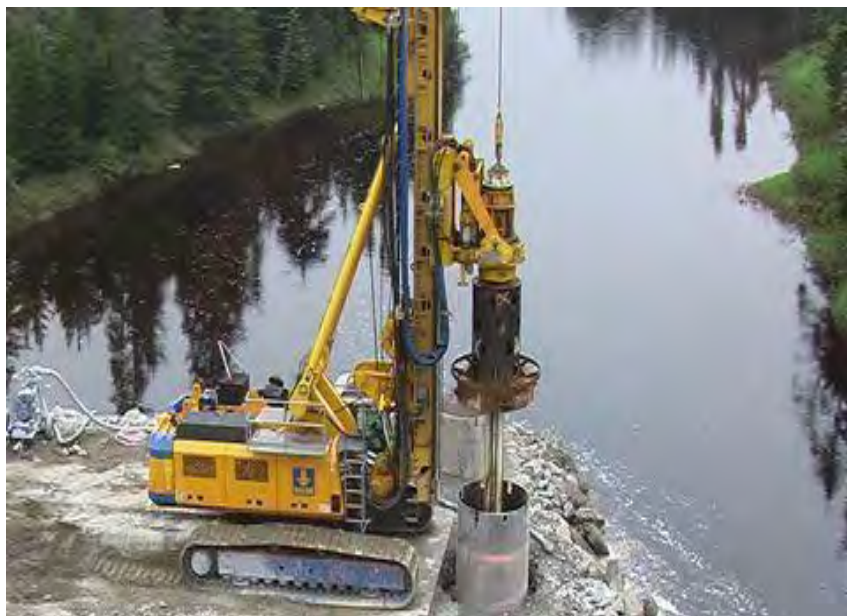
Figura 9: Formazione di pali di fondazione in alveo.
